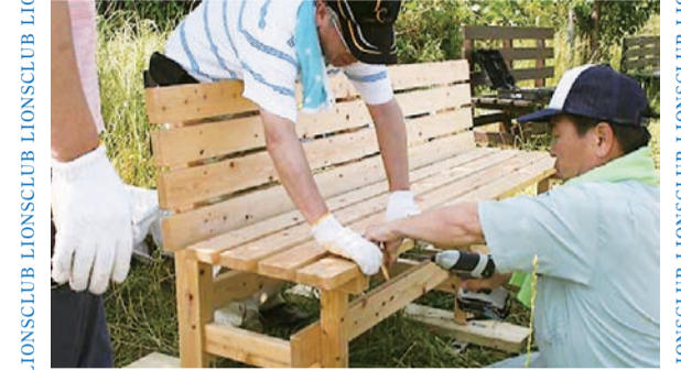
▲ベンチの足場固定作業
