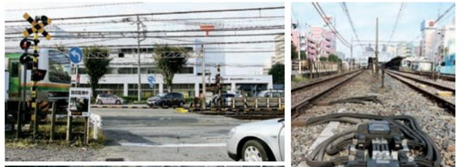
▲上尾駅・上尾郵便局前踏切み切りにて。電気踏切しゃ断機、電気転てつ機(写真左下)、インピーダンスボンド(右)は、いずれも上尾工場の主要な生産機器です
