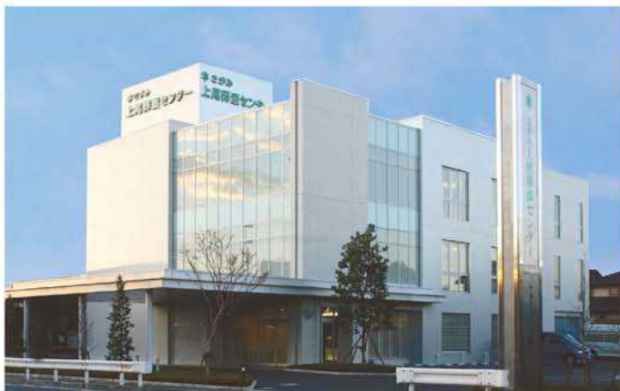
上尾葬斎センター 〒362-0001 埼玉県上尾市上274-1
