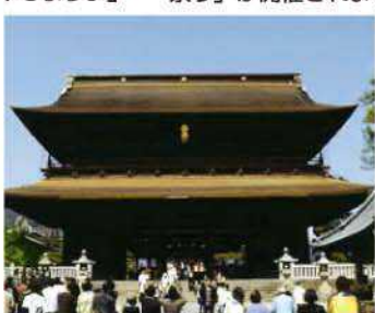
▲重要文化財・善光寺山門(三門)。平成大修理によって、建立当時と同じ、サワラの板を用いた檜葺き(とちぶき)に復元されました
