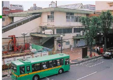
▲改修工事が着々と進んでいるJR上尾駅（東口）
