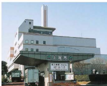
▲上尾市西貝塚環境センターは、80mの高さを誇る煙突がシンボル。ごみを燃やしたときの熱エネルギーは、蒸気タービン発電設備で電気(2080キロワット)をつくってセンター内で使用するほか、余った電気を電力会社に売っています。また、工場内の冷暖房・温水、健康プラザ「わくわくランド」の温水にも利用されます。
