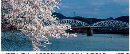
▲綾部大橋は、1929年に架けられた全長210m、幅5.2mのプレハブ橋。2005年、国有形文化財に登録されました。昭和初期の由良川の風景を伝える、現役の道路橋です。
