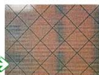
エコカラット施工後
