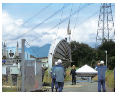
▲関東圏内のパラボラアンテナ更新工事。直径4mの巨大なアンテナがクレーンで吊り上げられていく様子はまさに圧巻！高度な技術と安全管理の徹底が同社の信条です(写真提供/埼玉三技協)
