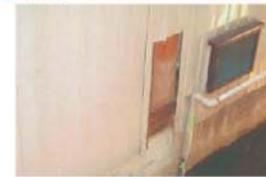
柱・土台・基礎を連結するため外壁を切って柱と土台を出します。
