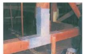
強力なエポキシ樹脂を塗り接合部を固めて密着させます。
