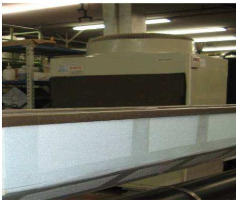
「断熱材を取り付けた冷却水槽」
